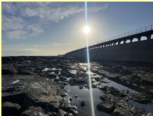
Blyth East Pier (/4001C05).
