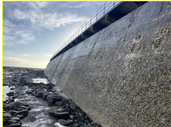
Blyth East Pier (/4001C05).
